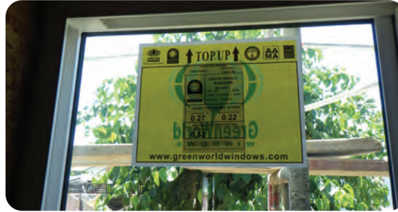
Window Replacement Reemplazo de ventanas
